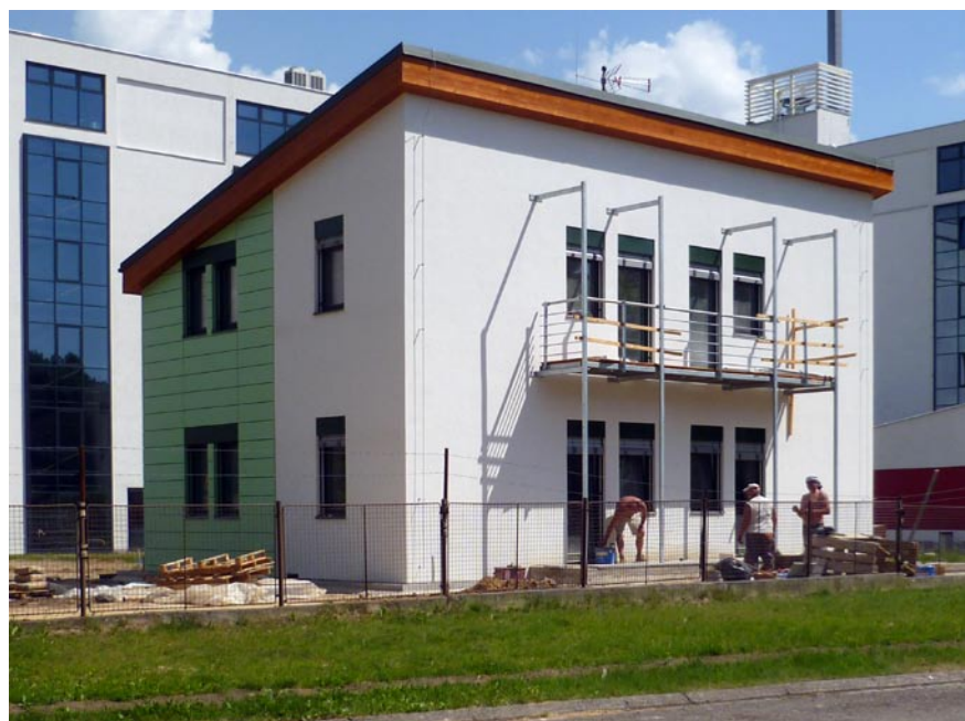
Výzkumné a inovační centrum MSDK realizované jako montovaná dřevostavba v pasivním energetickém standardu stojí v areálu Fakulty stavební, VŠB-TU Ostrava
